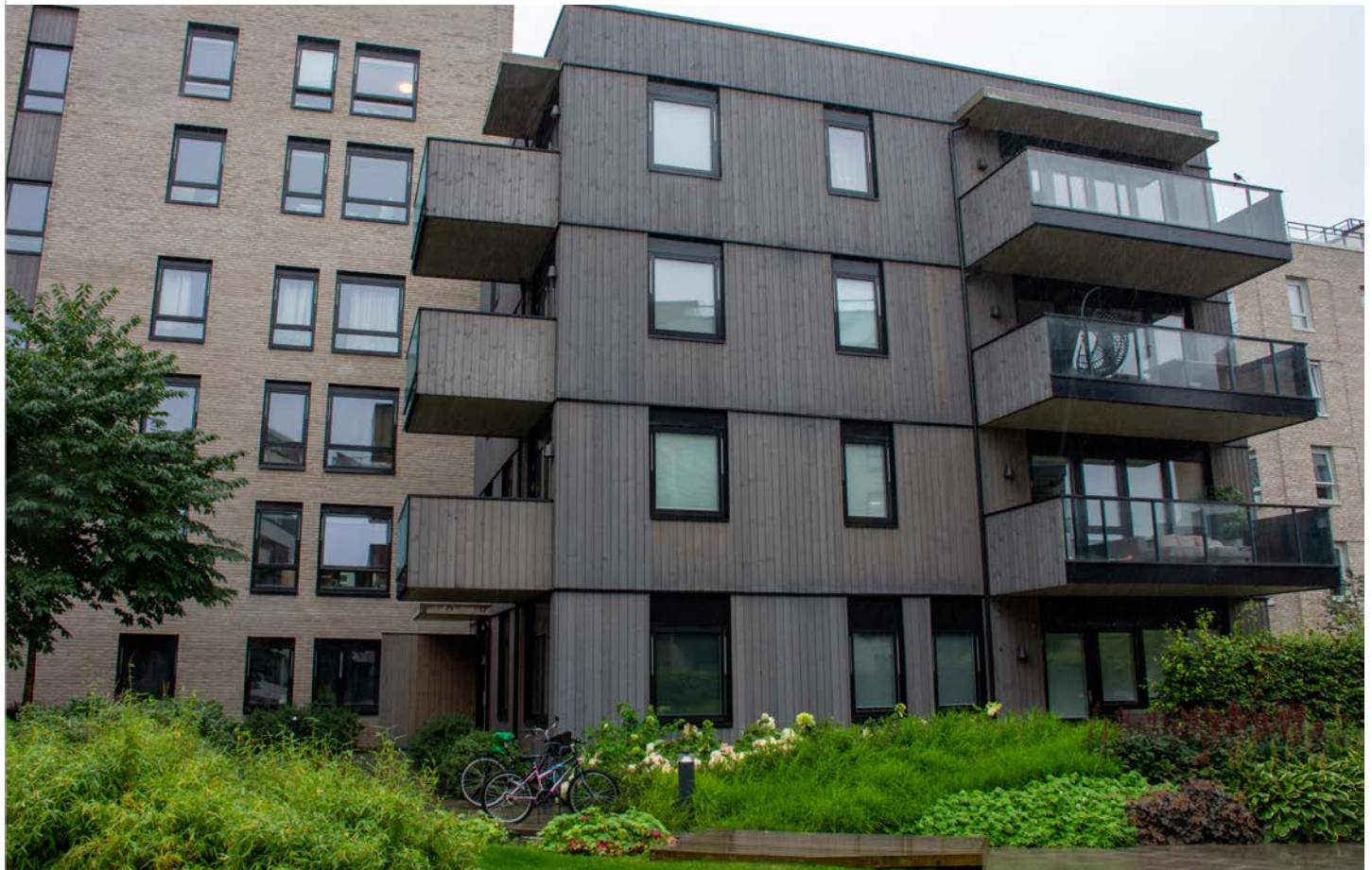
Wohnhaus in Norwegen. Vivid Silvered Shield Fassadenprofile 6 Jahre nach der Montage. Vertrieb: Moelven. Foto: Thermory
