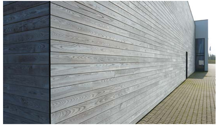
Unbehandelte Thermory Benchmark Thermo-Esche ein Jahr nach der Montage. Dänemark.
