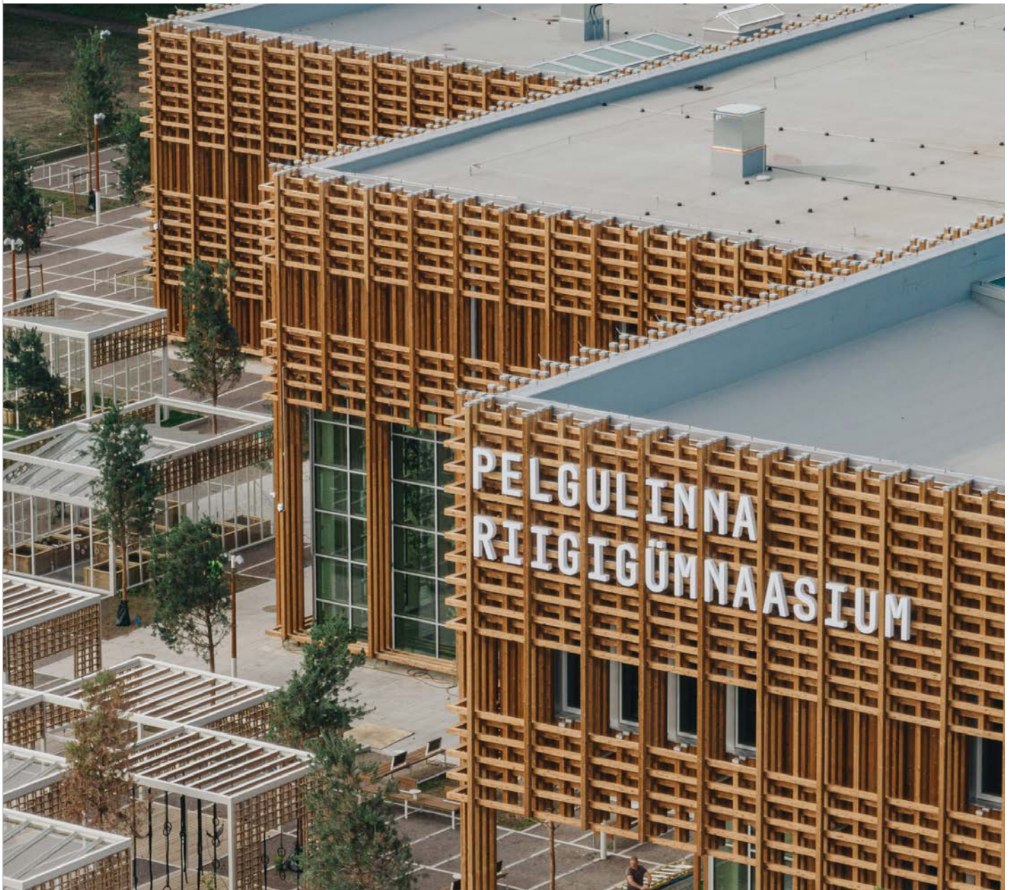
Thermory Thermo-Kiefer Pfosten mit Brandschutzimprägnierung by Woodsafe. Pelgulinna Staatliches Gymnasium, Estland. Architekt: Ott Alver. Foto: Tõnu Tunnel
