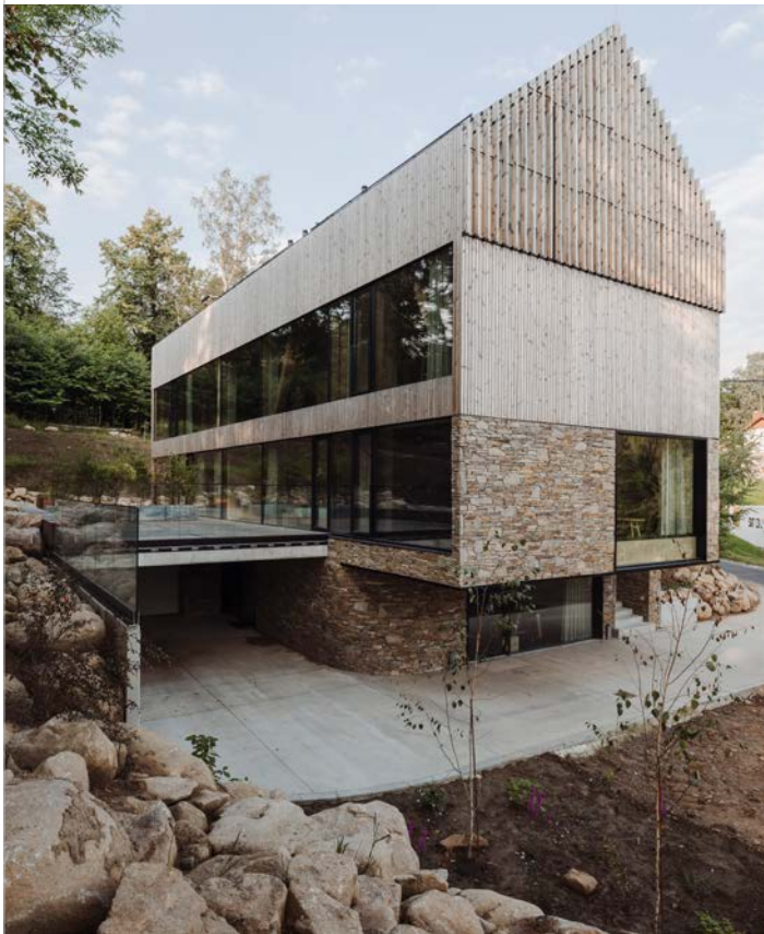
Unbehandelte Thermory Benchmark Thermo-Kiefer-Fassade ein Jahr nach der Montage. Wohnungen in Polen. Foto und Vertrieb: Komplex Market
