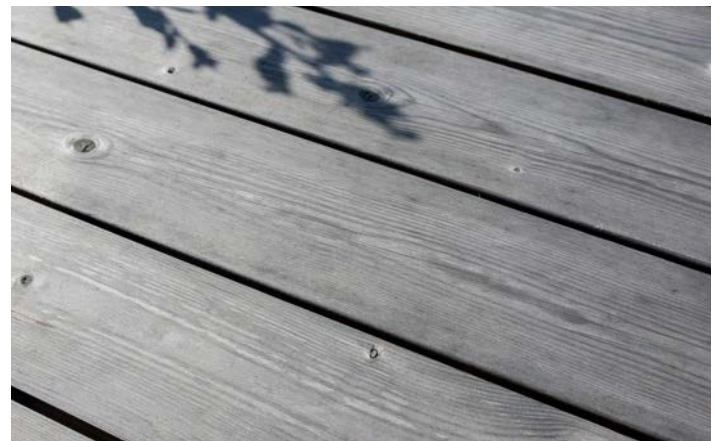
Ungeölte Thermory Benchmark Thermo-Kiefer Terrasse nach einigen Jahren.
