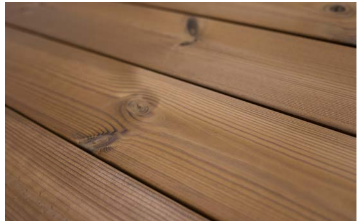
Ungeölte Thermory Benchmark Thermo-Kiefer Terrasse nach der Verlegung.
