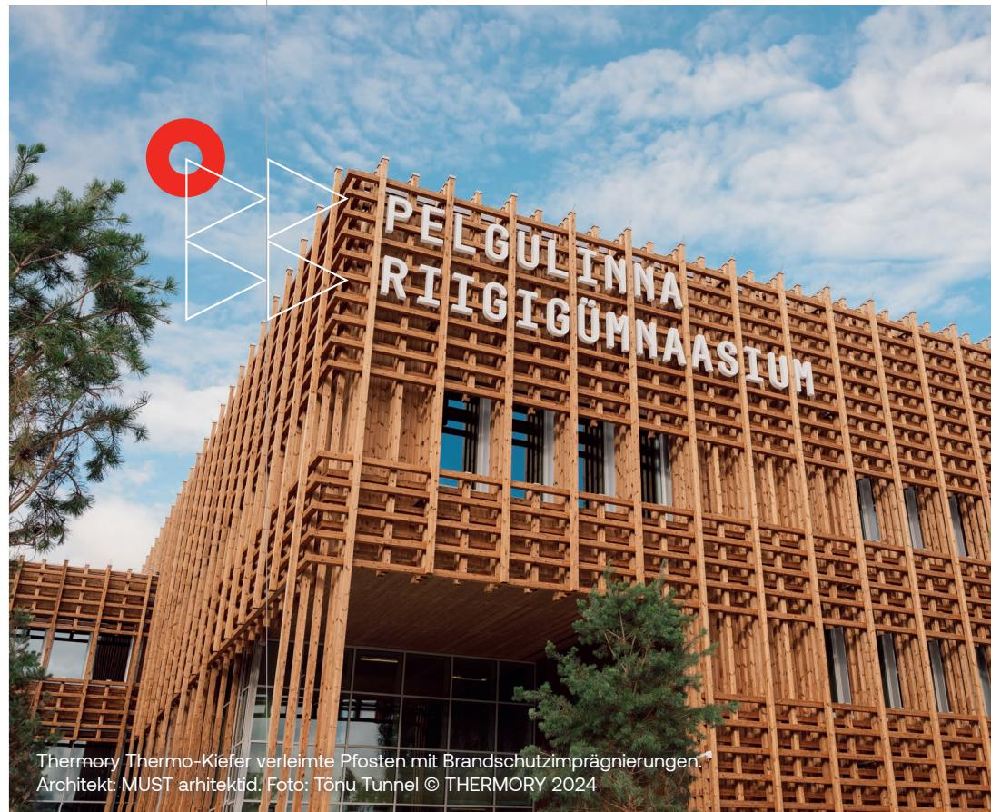
Thermory Thermo-Kiefer verleimte Pfosten mit Brandschutzimprägnierungen.
