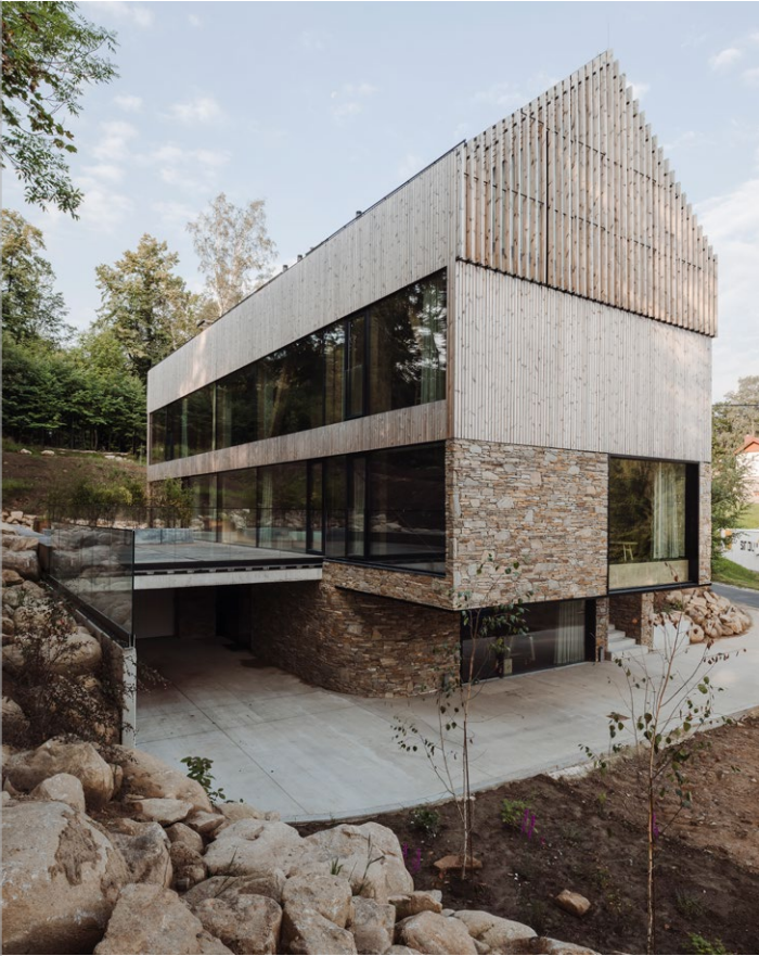
Õlitamata Benchmarki termomännist fassaad ja katus üks aasta pärast paigaldamist. Korterid Poolas. Foto ja turustamine: Komplex Market
