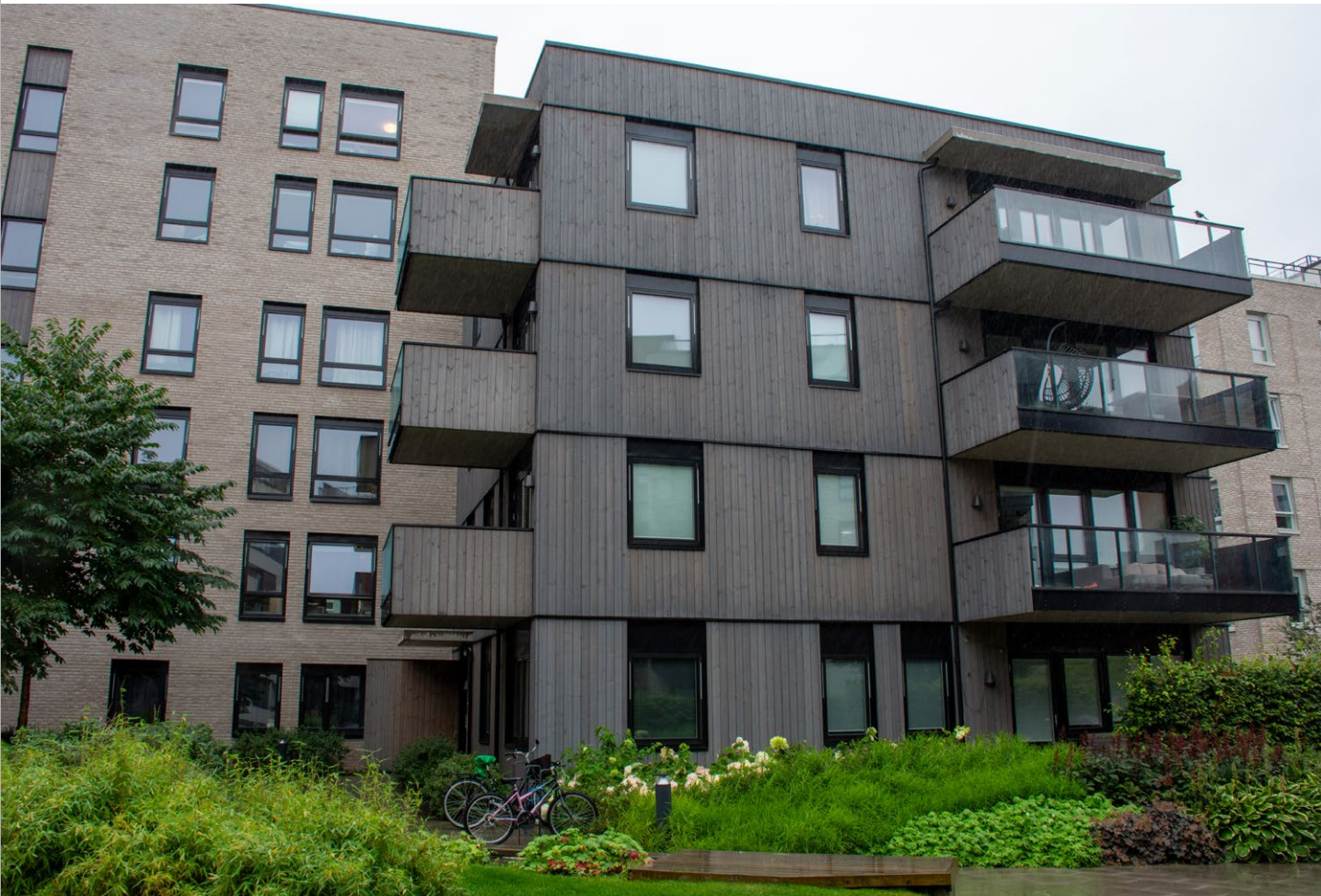
Elamu Norras. Voodrilauad Vivid Silvered Shield kuus aastat pärast paigaldamist. Turustaja: Moelven. Foto: Thermory
