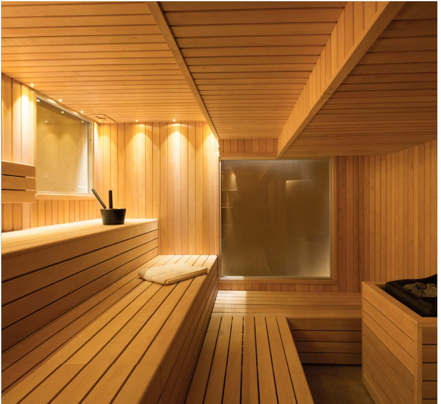
Saunan verhous on STP 15×90 mm:n leppää, lauteet SHP 28×90 mm:n leppää.
