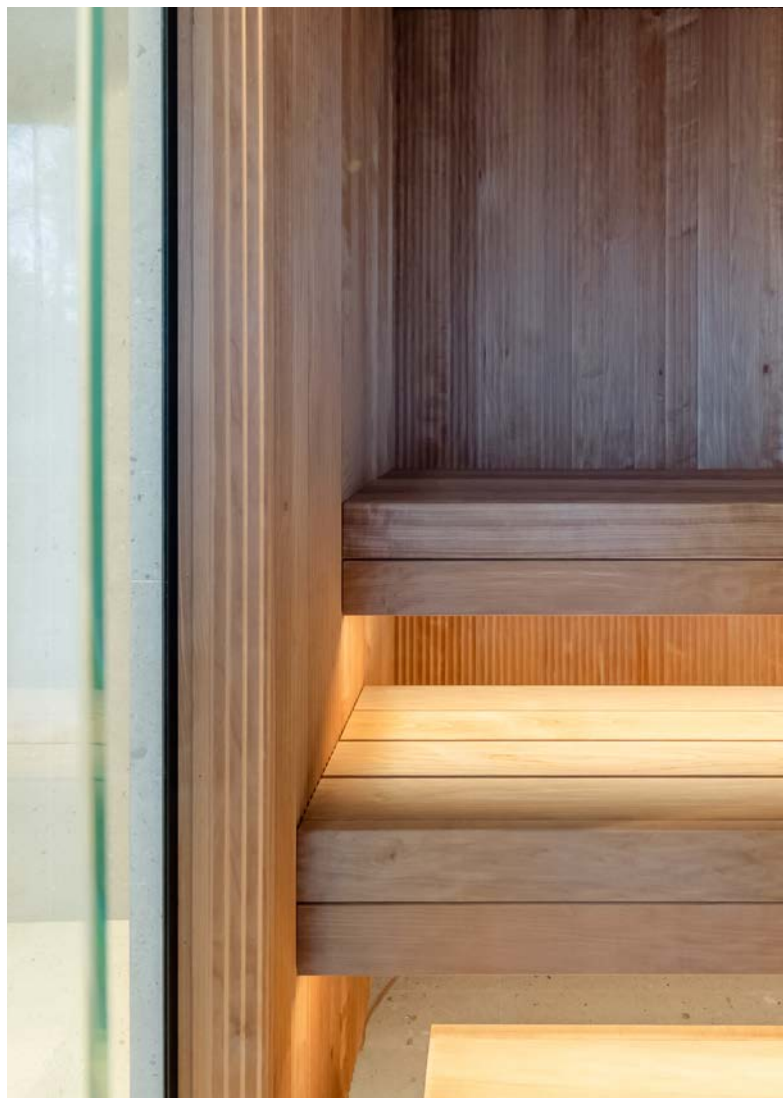
Seinäpaneelit ja katto: Vire 15x69 lämpöhaapa, laudelaudo: SHP 25x90 lämpöhaapa. Yksityiskoti, Viro. Kuva: Elvo Jakobson
