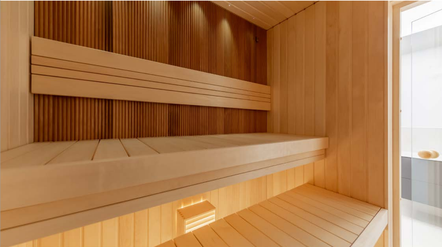
Seinäpaneelit: SRP lämpöhaapa ja STP haapa. Yksityiskoti Virossa. Kuva: Elvo Jakobson
