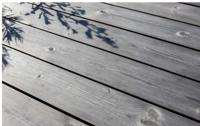
Thermory Benchmarki termomännist terrass, vananenud ja õlitamata
