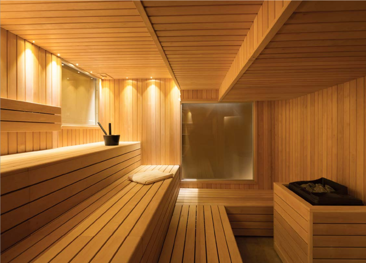
Seinäpaneelit: STP 15x90 leppä, laudelaudat: SHP 28x90 leppä. Spa-sauna Saksassa.
