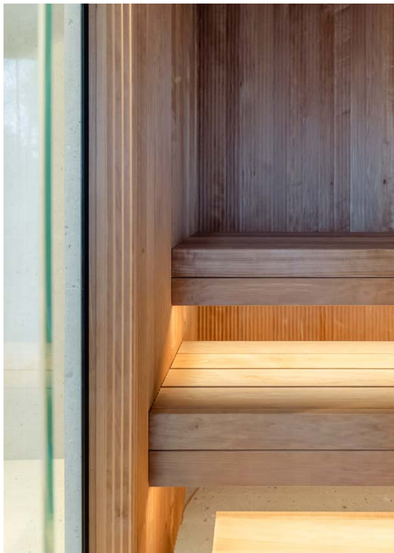
Seinavooder ja lagi: Vire 15x69 termohaab, lavalauad: SHP 28x90 termohaab. Erasaun Eestis. Fotograaf Elvo Jakobson
