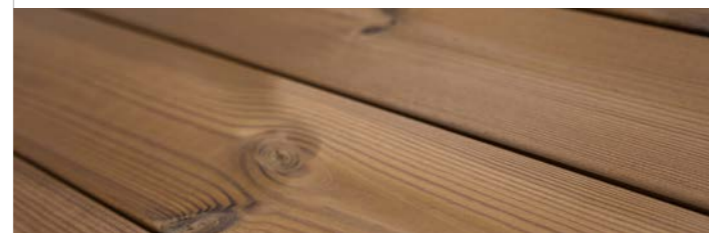
Õlitamata Thermory Benchmark termomännist terrass peale paigaldust
