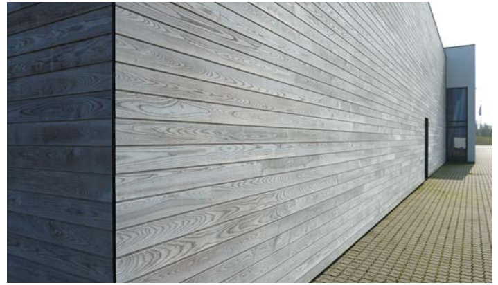
Ungeölte Thermory Benchmark Thermo-Esche ein Jahr nach der Montage Dänemark
